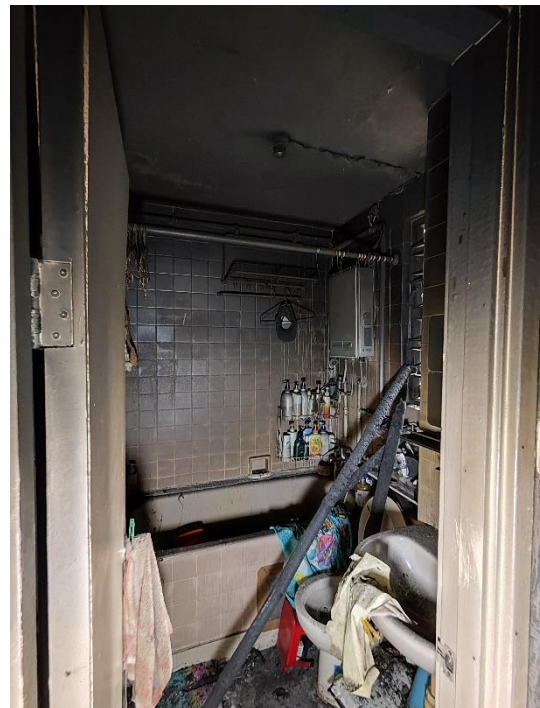
Photo 8-6 (d): Flat 03 Toilet
