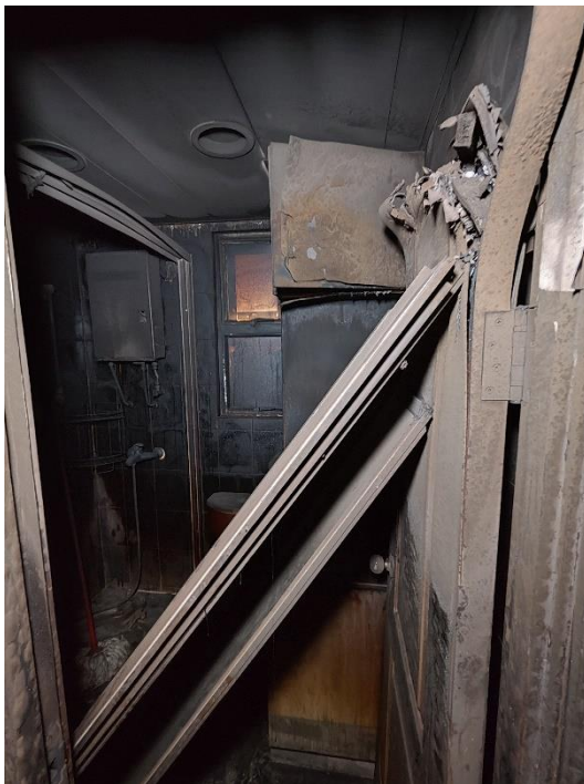
Photo 8-5 (d): Flat 02 Toilet
